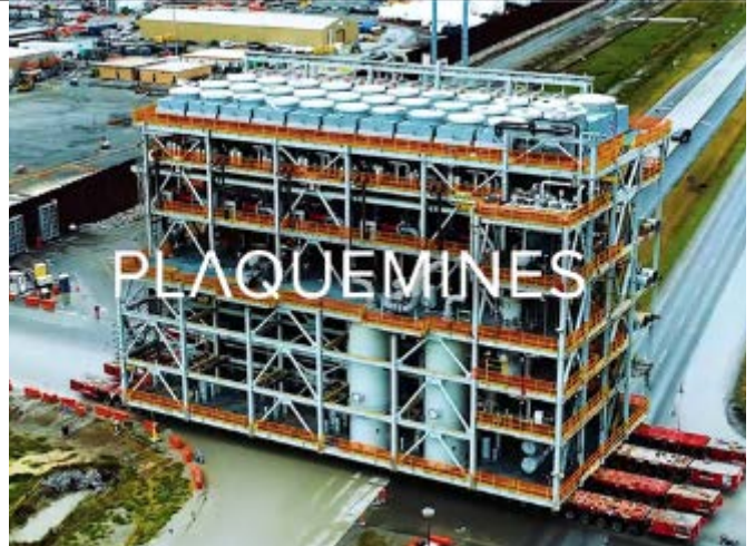
그림 203. 터미널에 설치되고 있는 Plaqueimnes LNG 모듈
